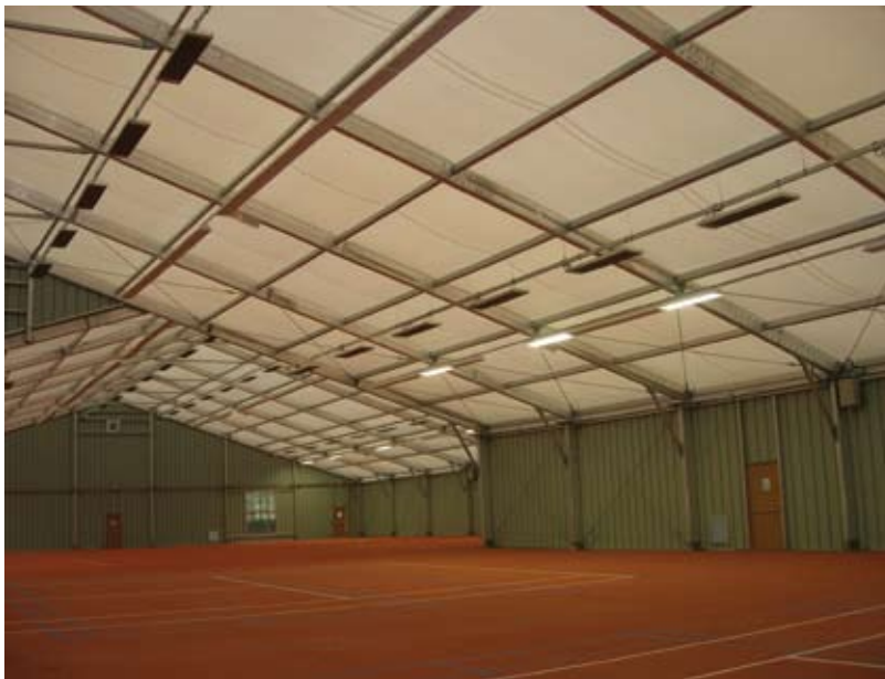
Приборы EZ300 идеальное решение для периодически используемых помещений. Обогрев работает только, когда в помещении находятся люди.
