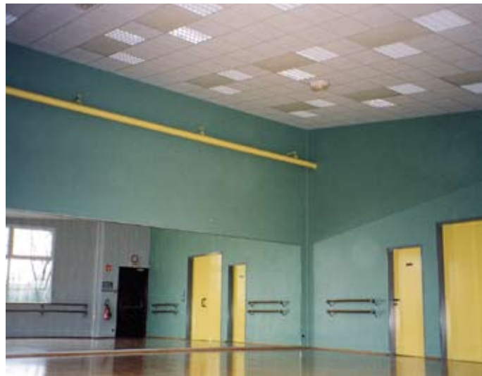
Инфракрасные обогреватели нагревают в первую очередь пол и другие предметы, поэтому им отдают предпочтение в тех случаях, когда люди могут находиться в помещении без обуви.
